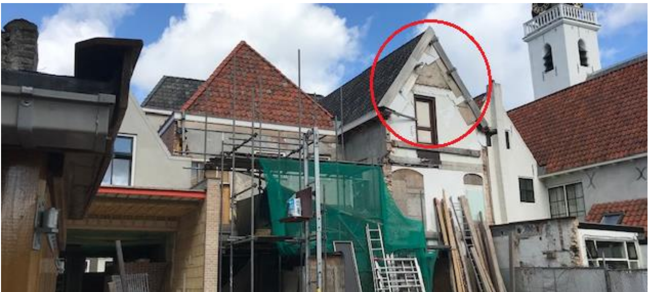
Figuur 4. Plaatmateriaal op kopgevel
