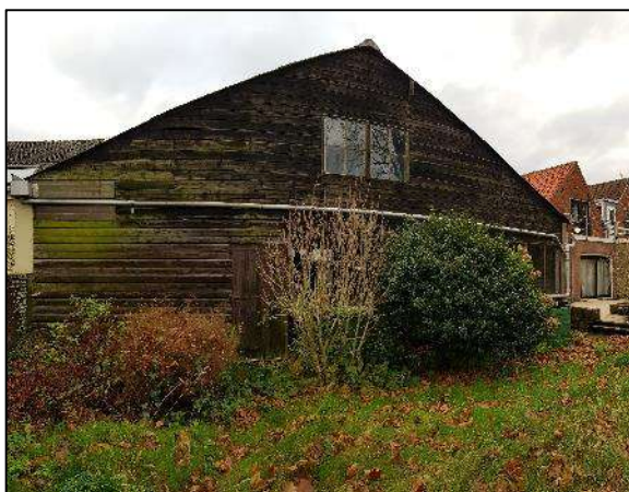
Foto 3: Achterzijde van het pand
