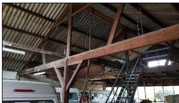
Foto 2: Binnen in het pand, de dak met draagbalken.
