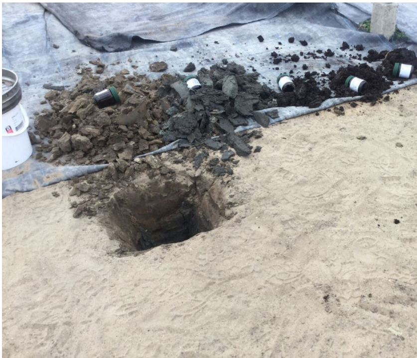
Afbeelding 5: gecombineerd bodem- en asbestonderzoek (inspectiegat en grondboring)
