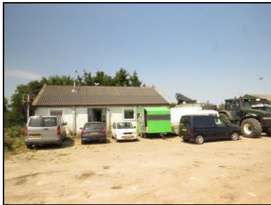
Figuur 3. Te slopen kantoorgebouw in het westen van de onderzoekslocatie.
