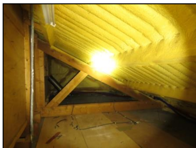
Figuur 10. Binnen aanzicht van het golfplaten dak van het kantoorgebouw, bespoten met isolatiemateriaal.
