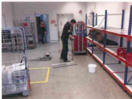
Foto 5 Inpandige boring (gestaakt wegens beton)
