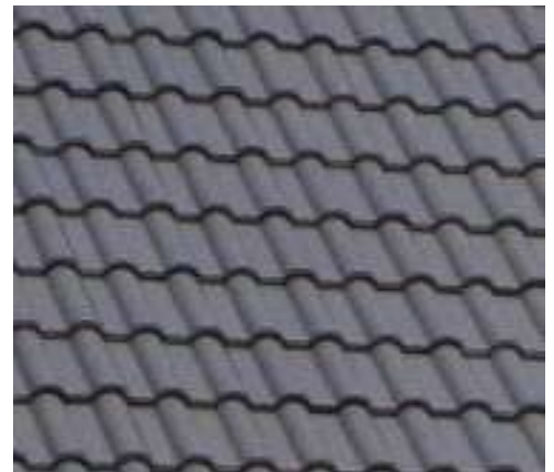
Schuine daken zijn voorzien van grijze dakpannen
