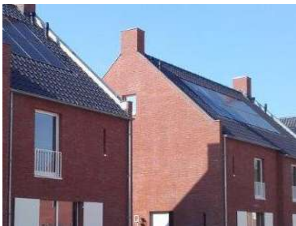
De gevels zijn opgetrokken in rood-bruin effen metselwerk
