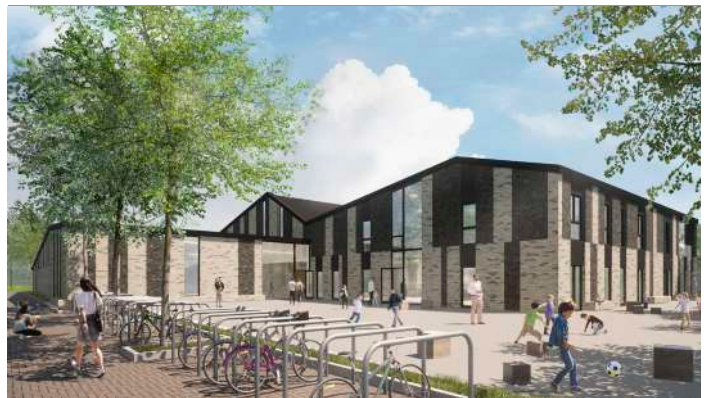
Impressie achterzijde gebouw. (bron: NOAHH)
