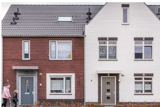
Aandacht voor detail van de voordeuren, voordeuren worden benadrukt met een lijst of een luifel.
