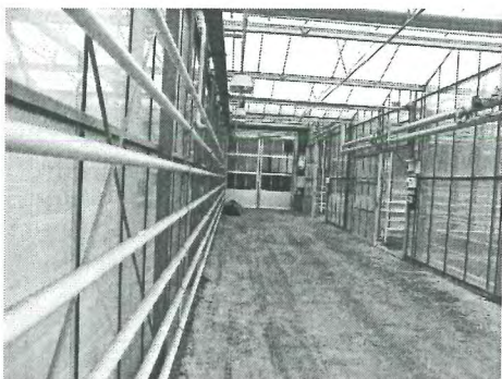
Kas naast loods (2 e ) met grotendeels betonvloeren.
