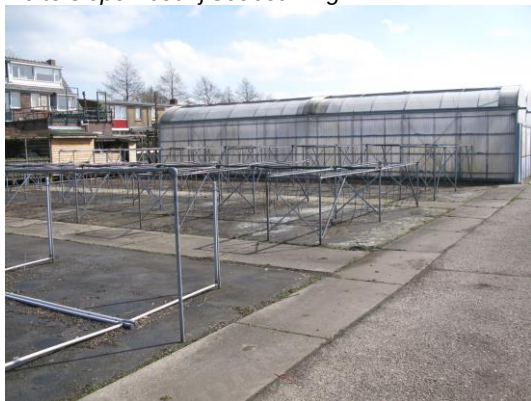
De te slopen bedrijfsbebouwing.
