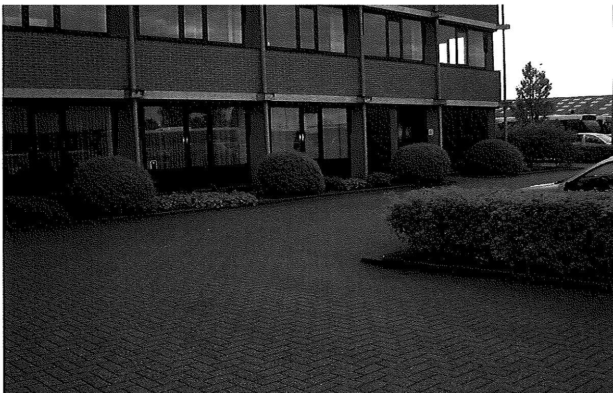
Foto 5: Westzijde nieuwbouw kantoor
