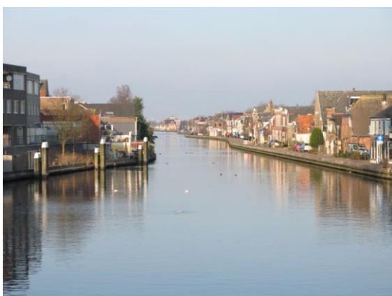
De Gouwe vanaf de hefbrug. Middenachter is de planlocatie nog net zichtbaar.
