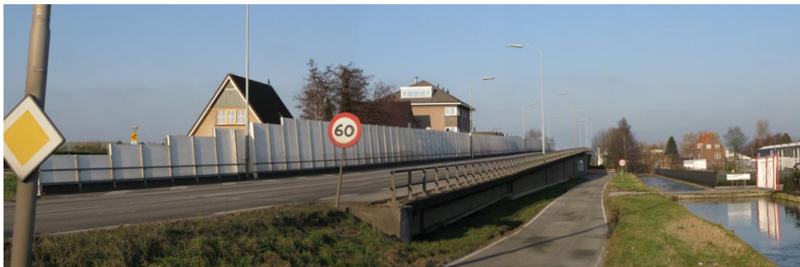
De N207. Achter het geluidscherm (ter hoogte van de boom) is het plangebied gelegen.
