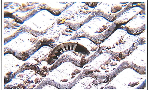
Foto 22: spinrag voor kapotte ventilatiepan
