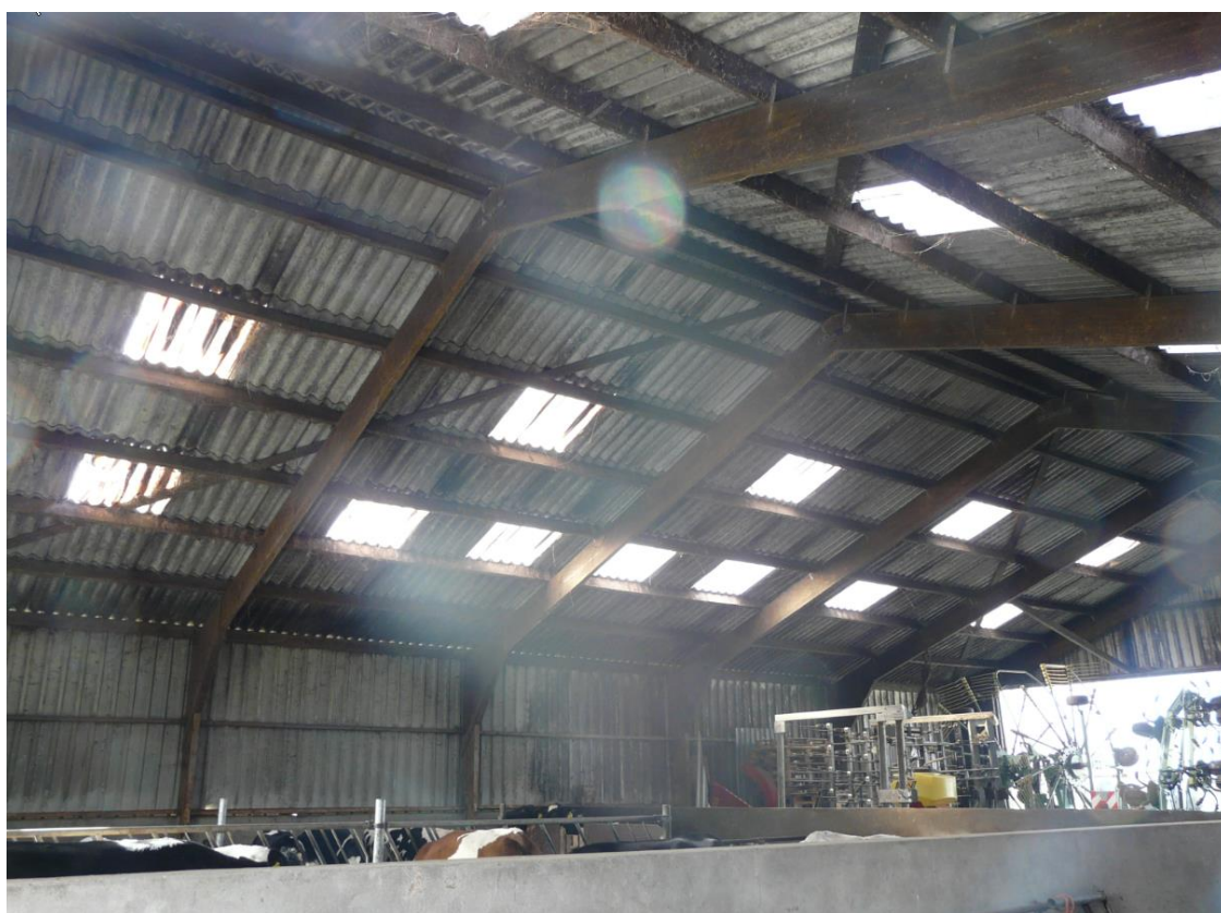
Foto 1 stal met bovenin dichte nok bestaande stal / loods
