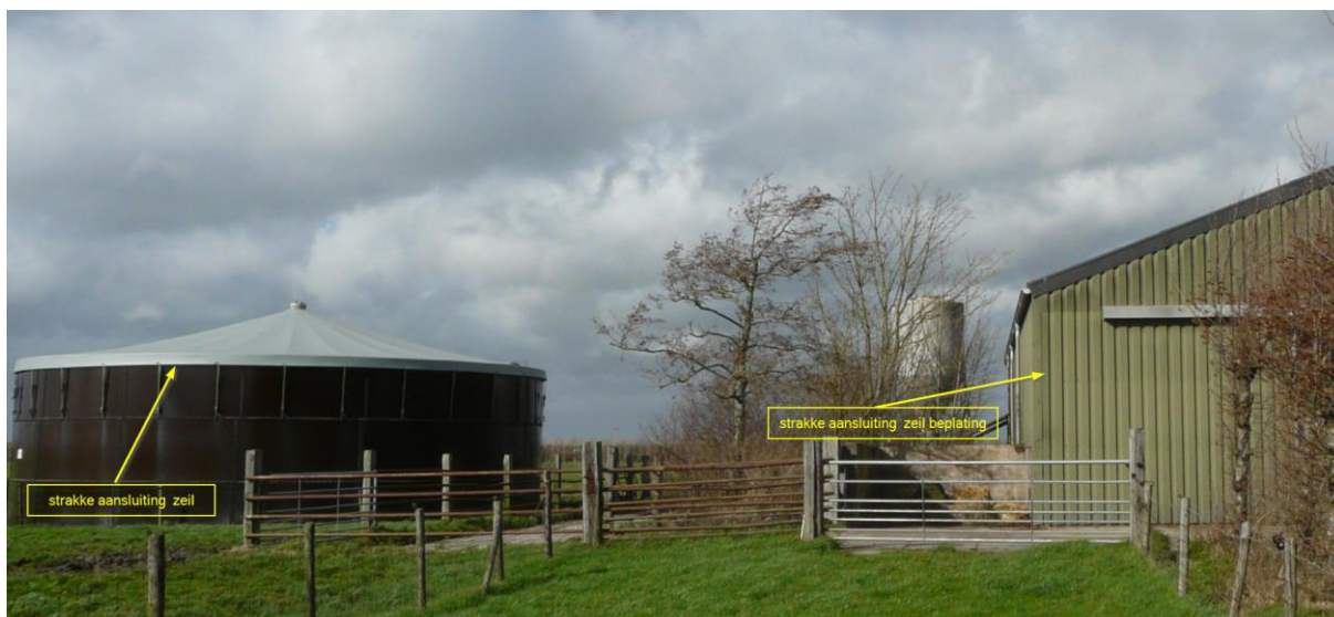
Foto 7. Aansluiting zeil en beplating
