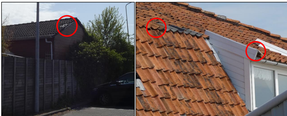
Figuur 6: Woningen aan de oostzijde van het plangebied. Vleermuizen, gierzwaluwen en huismussen kunnen hier niet worden uitgesloten.
