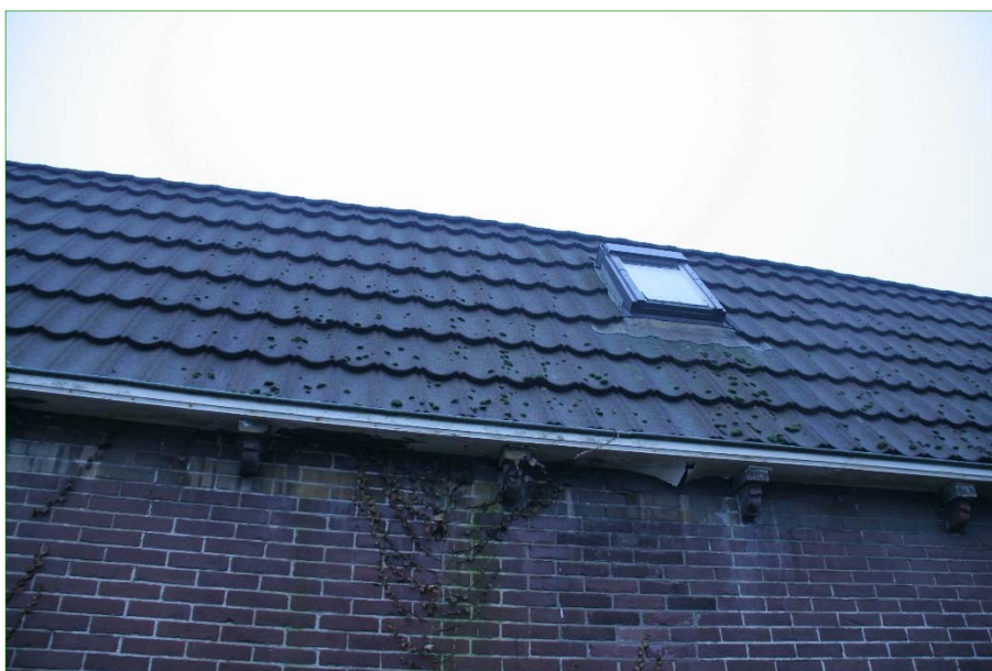
Dakpannen van de bebouwing sluiten meestal goed op elkaar aan.
