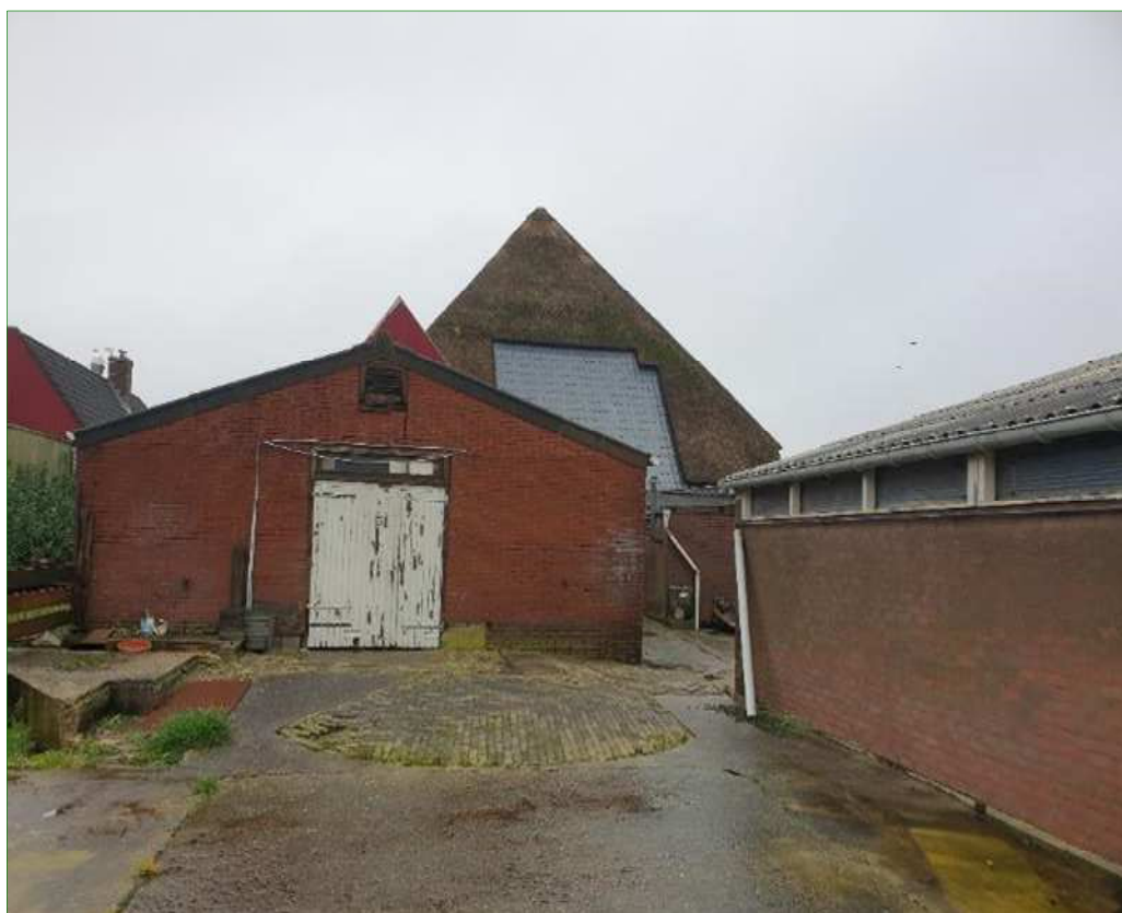
Achteraanzicht. In het midden de achterzijde van de stolpwooning met rieten dak en links een te behouden schuur.
