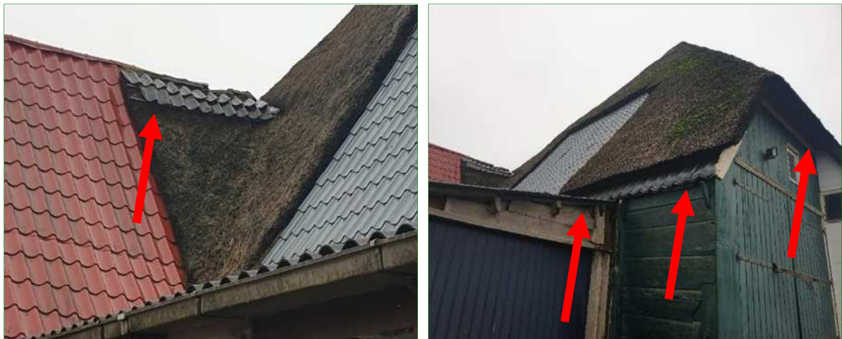
Diverse locaties waar vleermuizen kunnen invliegen naar mogelijk aanwezige achterliggende holtes nabij en in een te slopen garage tegen de stolpwooning.
