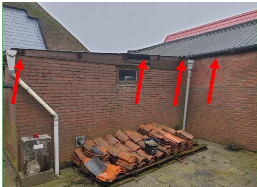
De te slopen voormalige melkruimte. ook met potentieel geschikte openingen voor vleermuizen (en Huismus).
