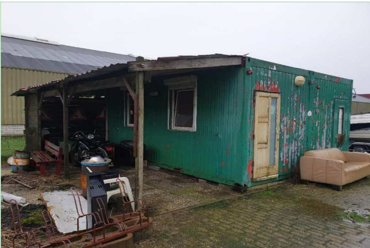
Het te slopen hok achter de grote loods.
