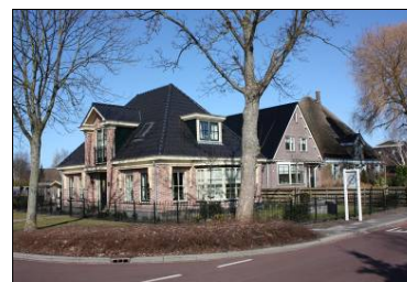
Nieuwbouw gebaseerd op traditionele gebiedseigen bouwvorm.
