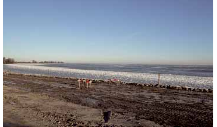
Dijkversterking tussen Enkhuizen en Hoorn.
