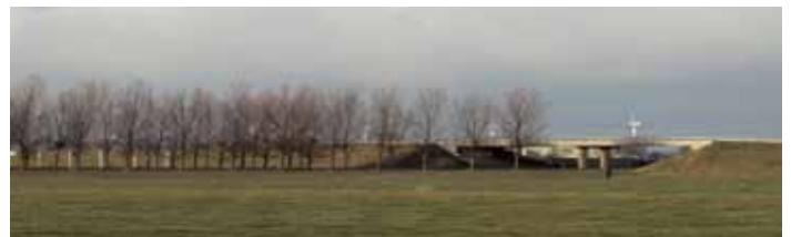
De N242 doorsnijdt de dijk bij Winkel.
