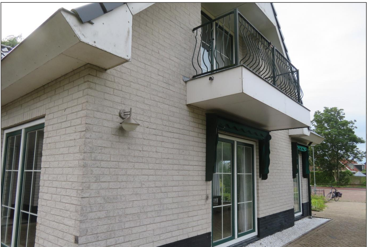
Afb 18: Geen openingen in metselwerk. Dichte aansluitingen
