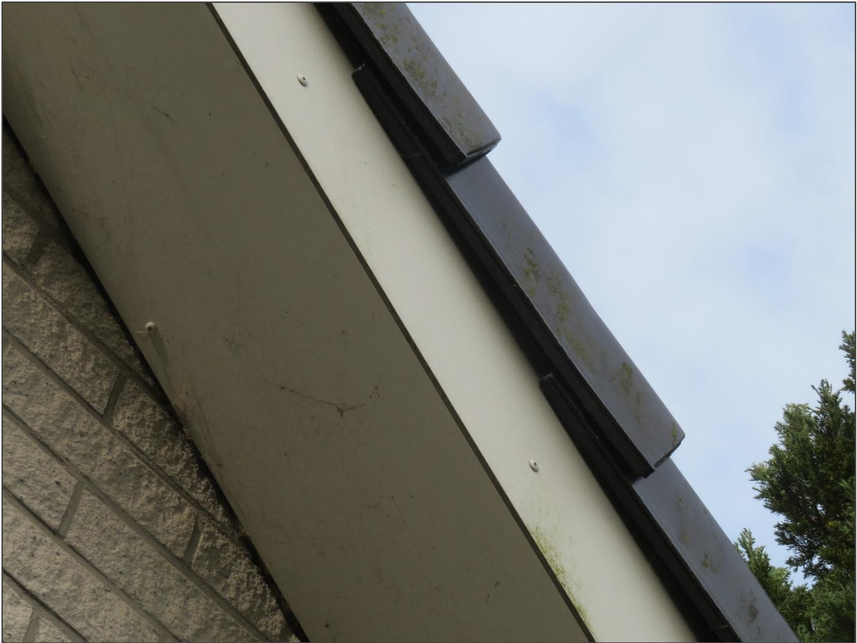
Afb 13: Trespa sluit strak aan op gevelmetselwerk, trespa te glad voor vleermuizen om vast te kunnen grijpen
