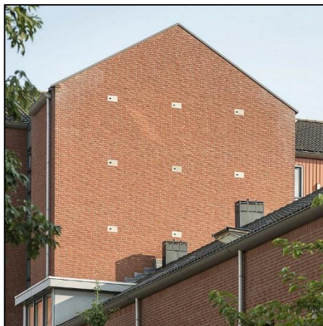
Afb 26 + 27: Gierzwaluwkasten ingemetseld (worden ook gebruikt door Huismussen)
