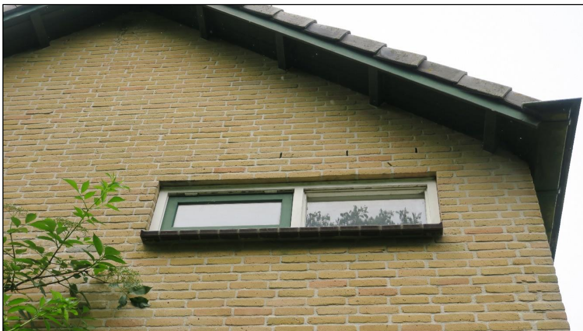
Figuur 3.3 De luchtsponw is voor vleermuizen toegankelijk via stootvoegen aan de zuidoost gevel. Daarnaast is de ruimte tussen dak en dakbeschot toegankelijk via de openingen tussen de kantpannen en de houten dakoverstek.
