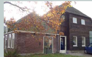
erfbebouwing: houten gevels en bakstenen gevels
