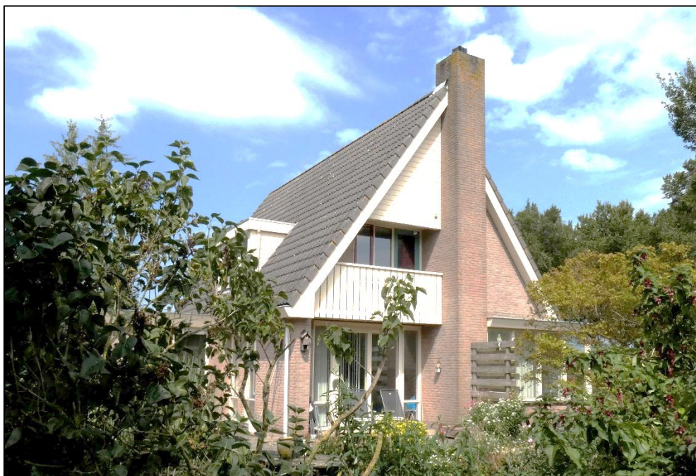
Figuur 10: De aanwezige woning heeft een zeer stijl dak, waardoor onder de dakpannen weinig mogelijkheid is om een nest te maken.
