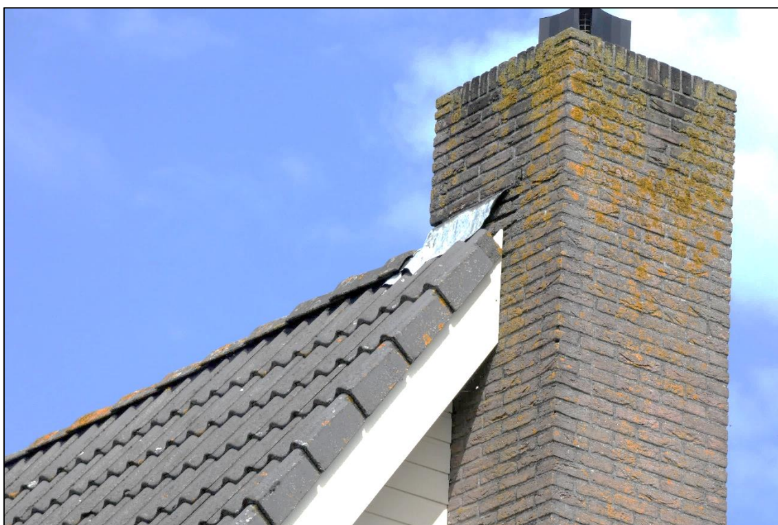
Figuur 11: In de aanwezige woning net buiten het plangebied kunnen verblijfplaatsen van dwergvleermuizen en laatvliegers aanwezig zijn onder dakpannen en loodslabben.
