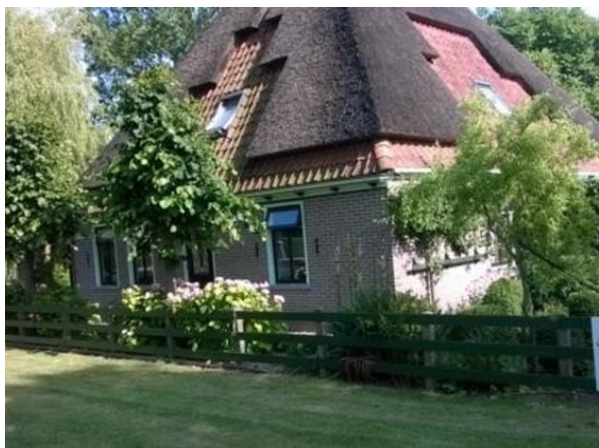
afb. 3 Het hoofdegebouw: de Stolp.
