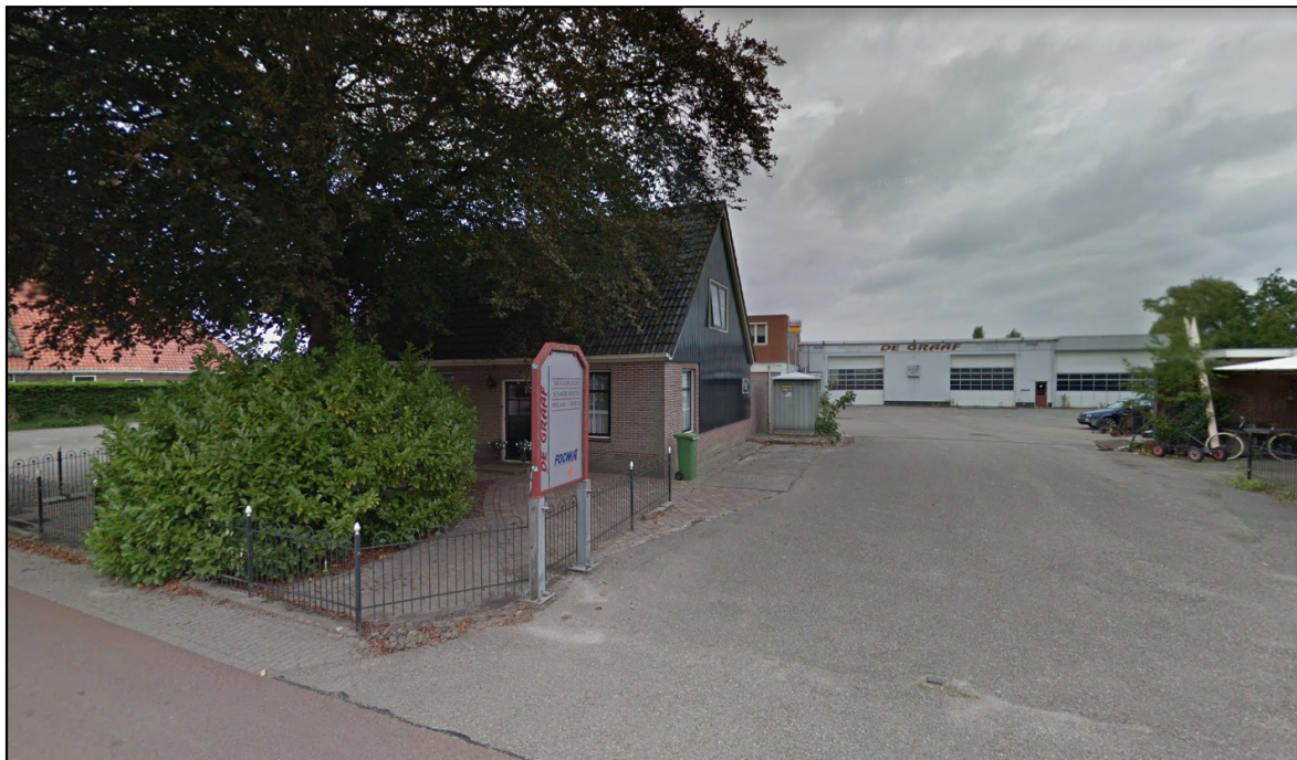
Figuur 3: Locatie Vreeker BV aan De Buurt 116 in Venhuizen in de huidige situatie
