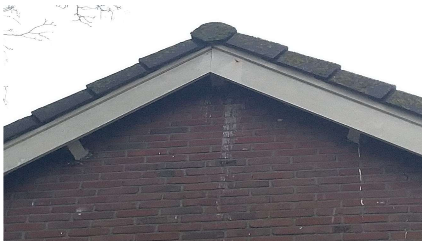
Afbeelding 10: Tussen de kantpannen en houten gevel is voldoende ruimte aanwezig voor vleermuizen en vogels. De witte poepsporen in de nok zijn hoogst waarschijnlijk van boomkruipers. Foto: M.S. de Haan / Ecoresult B.V.
