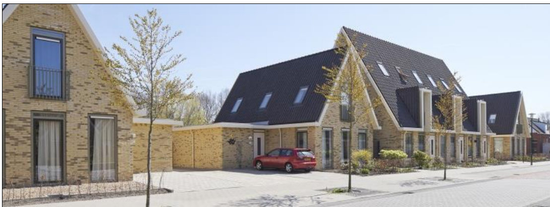
Figuur 20. Eigentijdse rijenwoningen
