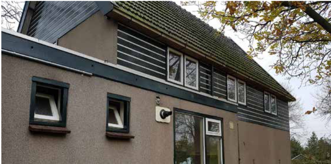
Betimmerigen sluiten strak aan op de muur - er zijn geen sporen van vleermuizen zichtbaar.
