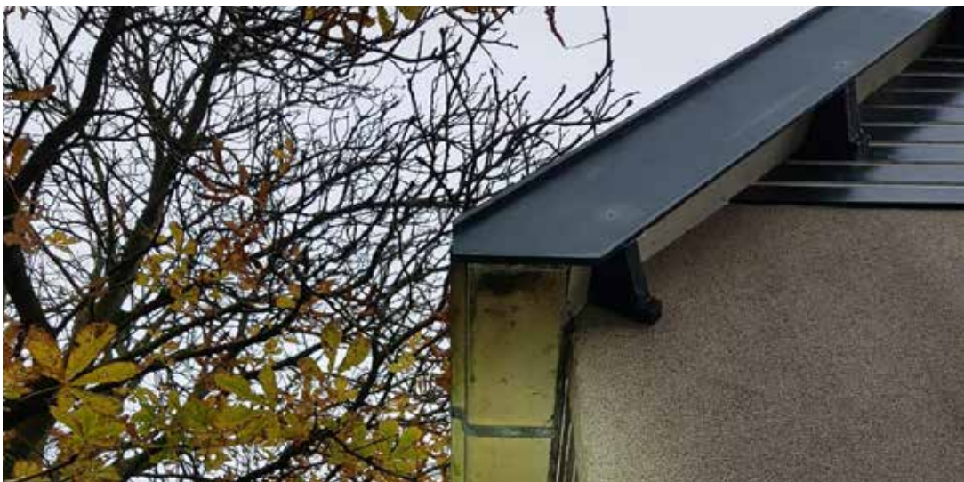
In aansluitingen van goten en betimmeringen zijn geen openingen aanwezig.
