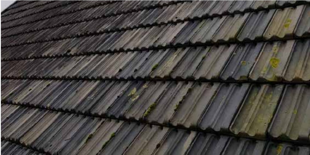
Het pannendak met straksluitende dakpannen.
