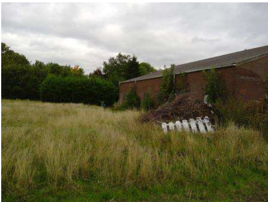
Foto 18: Overzichtsfoto dak deellocatie A
