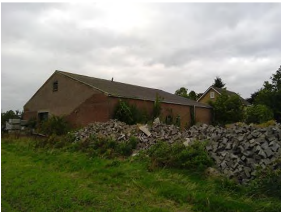
Foto 17: Overzichtsfoto dak deellocatie A
