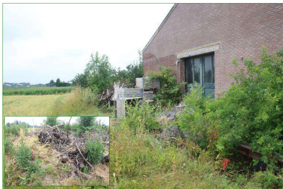
Zuidzijde van de opslagloods met takkenstapels en puin op de voorgrond.
