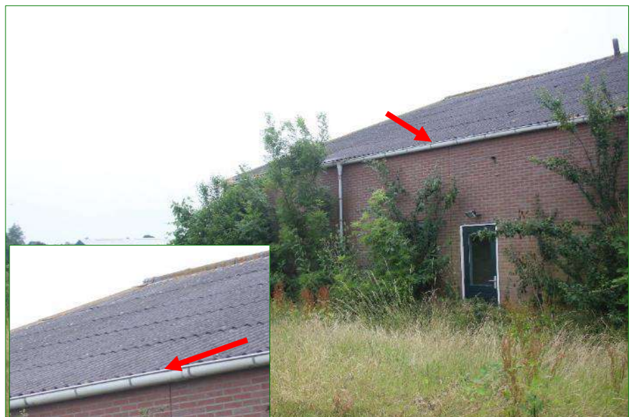
De openingen onder de golfplaten (rode pijlen) geven mogelijk toegang tot voor Huismus geschikte achterliggende ruimtes.
