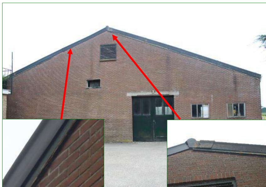
De holtes en kieren in de bebouwing bieden mogelijk toegang tot voor vleermuizen geschikte achterliggende ruimtes.
