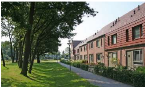
Rijwoningen met verschillende goothoogten
