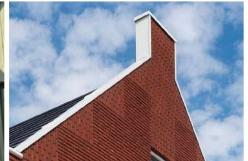
Verbijzondering in het metselwerk
