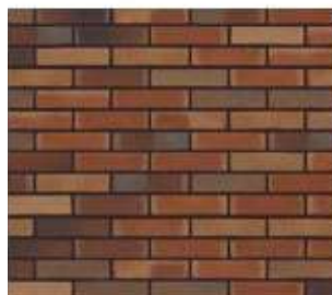
Metselwerk range rood tot bruin
