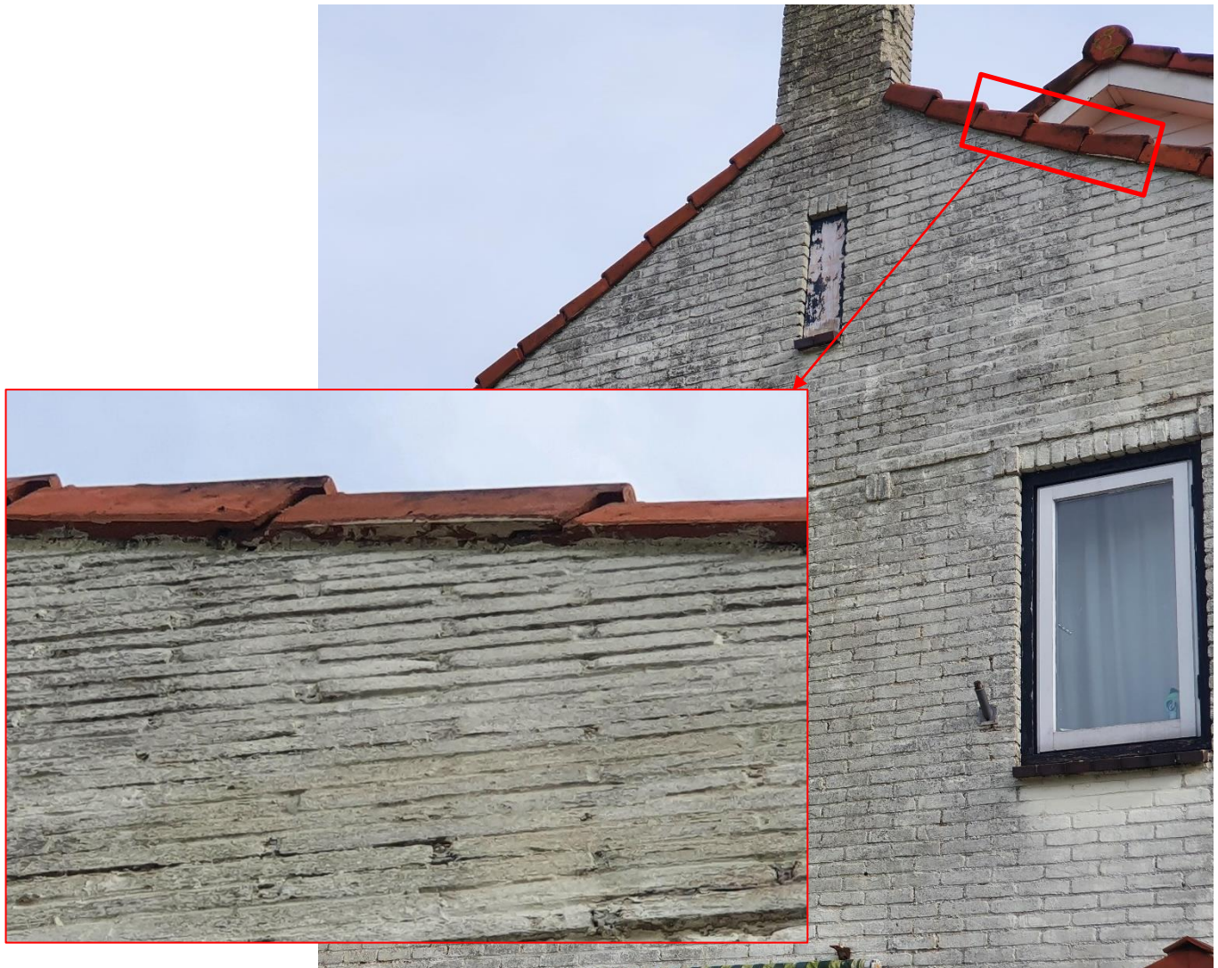
Figuur 20: Geveldakpannen die aan beide kopse kanten van de woning volledig aansluiten op de muur, waardoor er geen speleten aanwezig zijn of wegkruipmogelijkheden worden geboden voor Gierzwaluwen.
