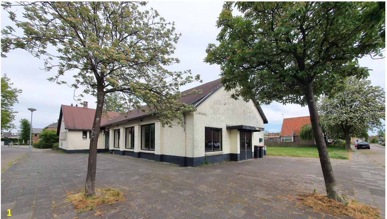
Figuur 6: Voorzijde verenigingsgebouw/hoofdgebouw aan noordkant van plangebied.
