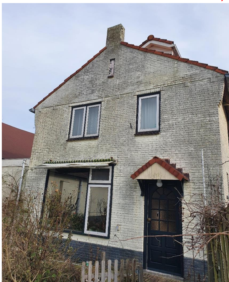
Figuur 8: Voorkant (westzijde van plangebied) van de woning, die achter het hoofdgebouw staat.
