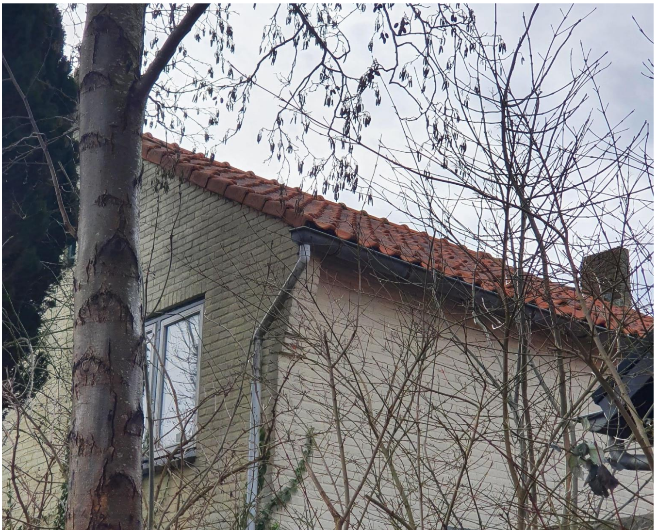
Figuur 18: Noordzijde van het dak, die vanwege een lastige positie, niet geheel te fotograferen was, maar met de verrekijker volledig is geïnspecteerd op spleten of losliggende dakpannen. Deze ontbraken aan deze zijde.
