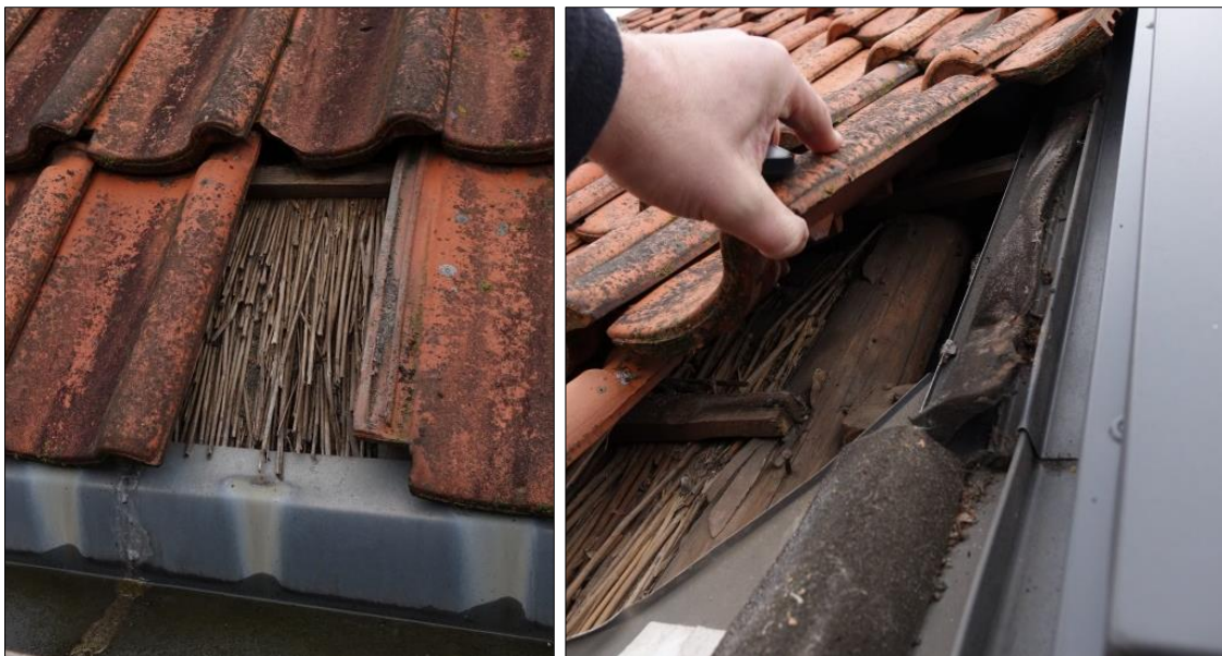
Dakpaninspectie ter hoogte van het aan te bouwen gedeelte van de stolp (1 maart 2019)
