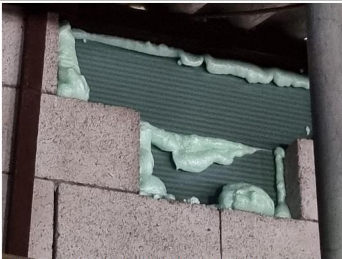
Grotere gaten afgedicht met een plaatmateriaal en daarna afgepuurd
