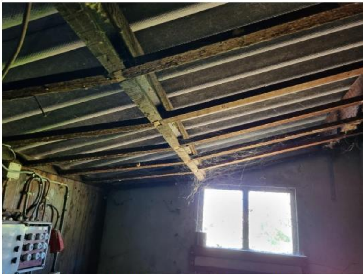
Door het ontbreken van plafonds alles goed controleerbaar op nesten. Deze zijn niet aanwezig
