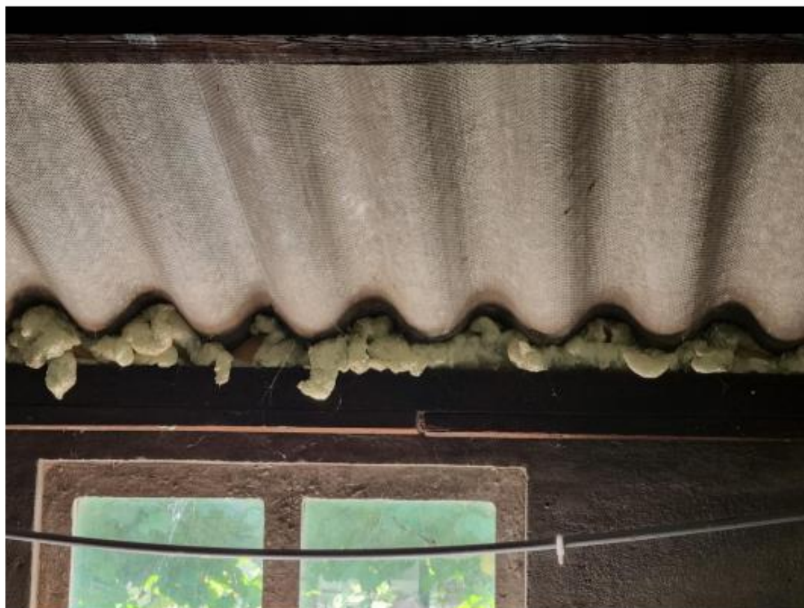
Golven van platen afgedicht met PUR-schuim
