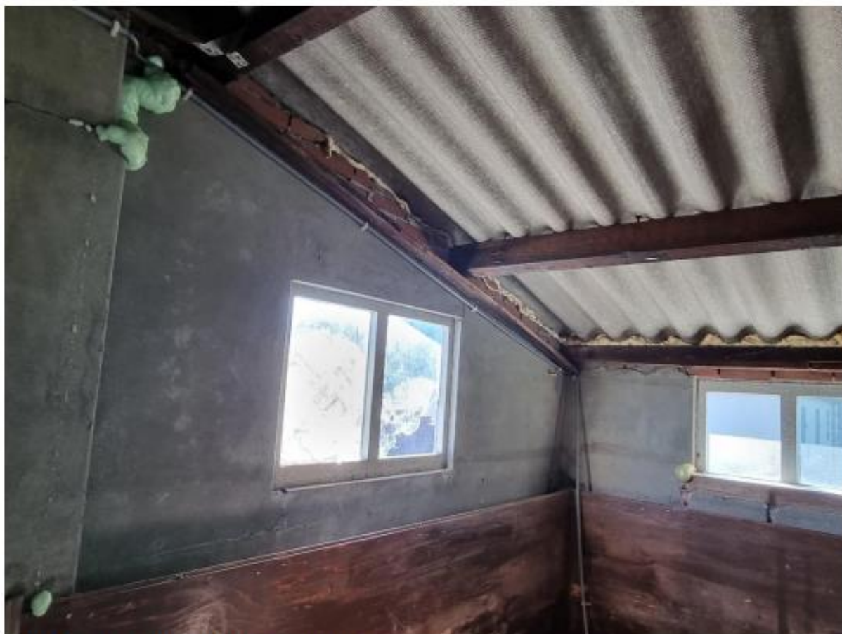
Ook hier alle kieren en gaten afgedicht
