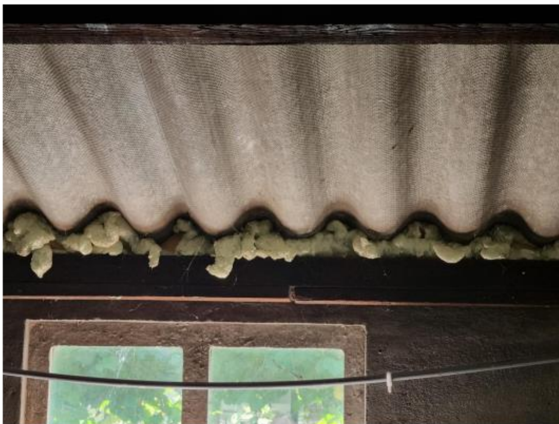
Golven van platen afgedicht met PUR-schuim
