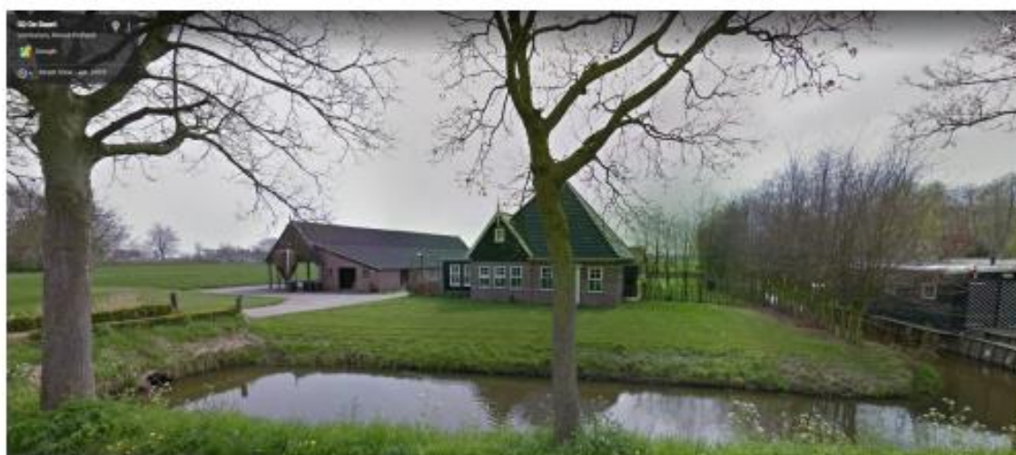
Figuur 11 Huidige situatie erf met stolp, schuur en erfbepplanting langs westkant van het erf
