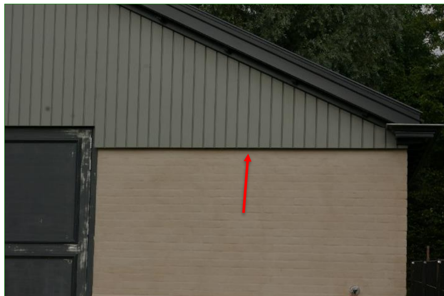
De openingen in de spouwmuur (rode pijl) aan de kopse kant van de gesloten schuur geven mogelijk toegang tot voor vleermuizen geschikte achterliggende ruimtes.
