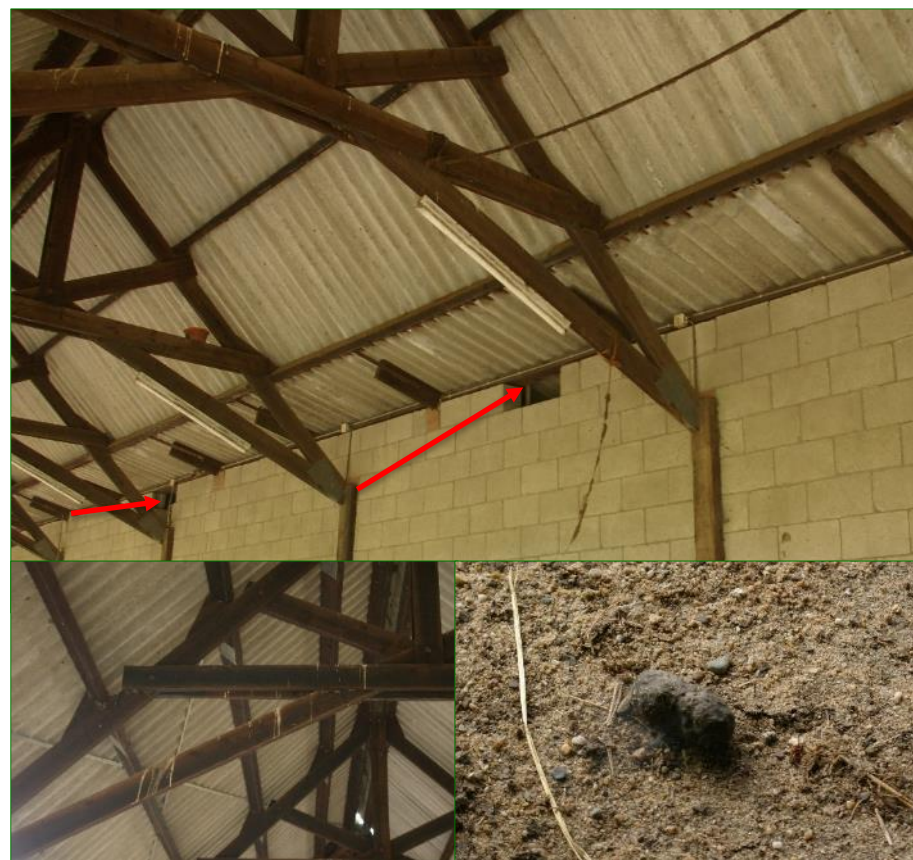
De openingen in de muur (rode pijlen) geven toegang tot voor Kerkuil geschikte achterliggende ruimtes. Linksonder een impressie van poepstrepen. Rechtsonder een aangetroffen uilenbal op de grond van het open deel van de stal
