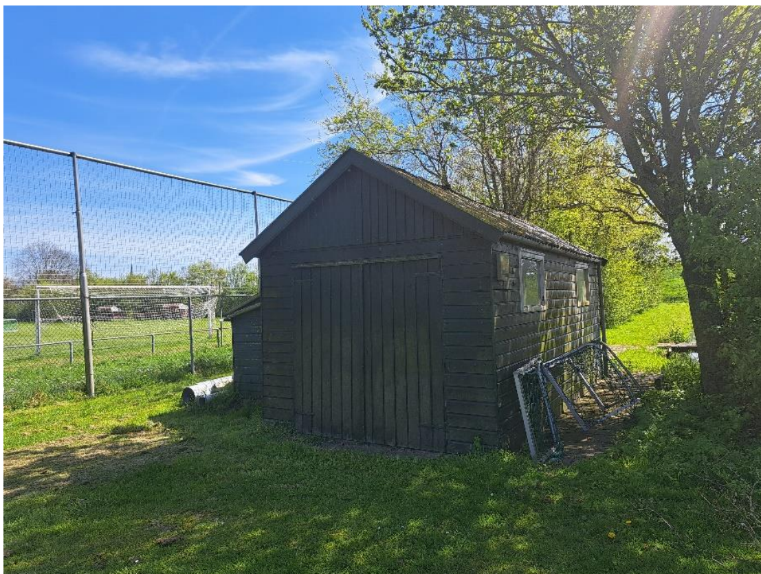
Eén van de te slopen opstallen binnen het projectgebied
