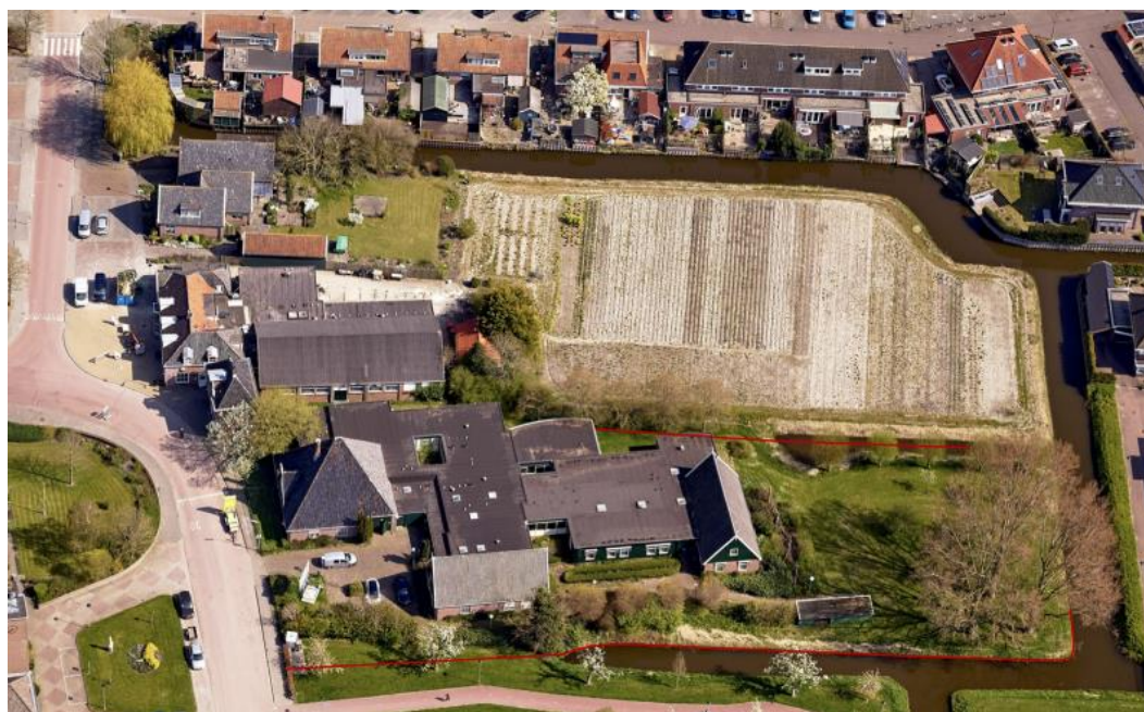
Luchtfoto huidige situatie
