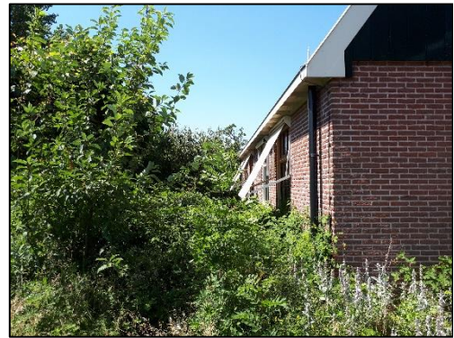
Aanzicht zuidelijke zijde complex
