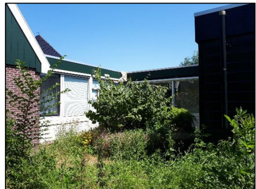
Aanzicht westelijke zijde complex
