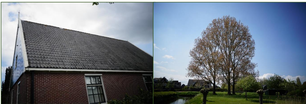
Figuur 5 Bebouwing met dakpannen als dakbedekking (links). Tuin met enkele grote Populieren en knotwilgen (rechts).
