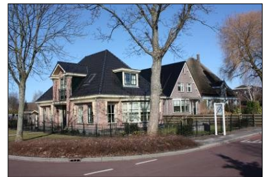
Nieuwbouw gebaseerd op traditionele gebiedseigen bouwvorm.
