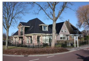
Nieuwbouw gebaseerd op traditionele gebiedseigen bouwvorm.
