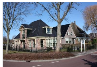
Nieuwbouw gebaseerd op traditionele gebiedseigen bouwvorm.
