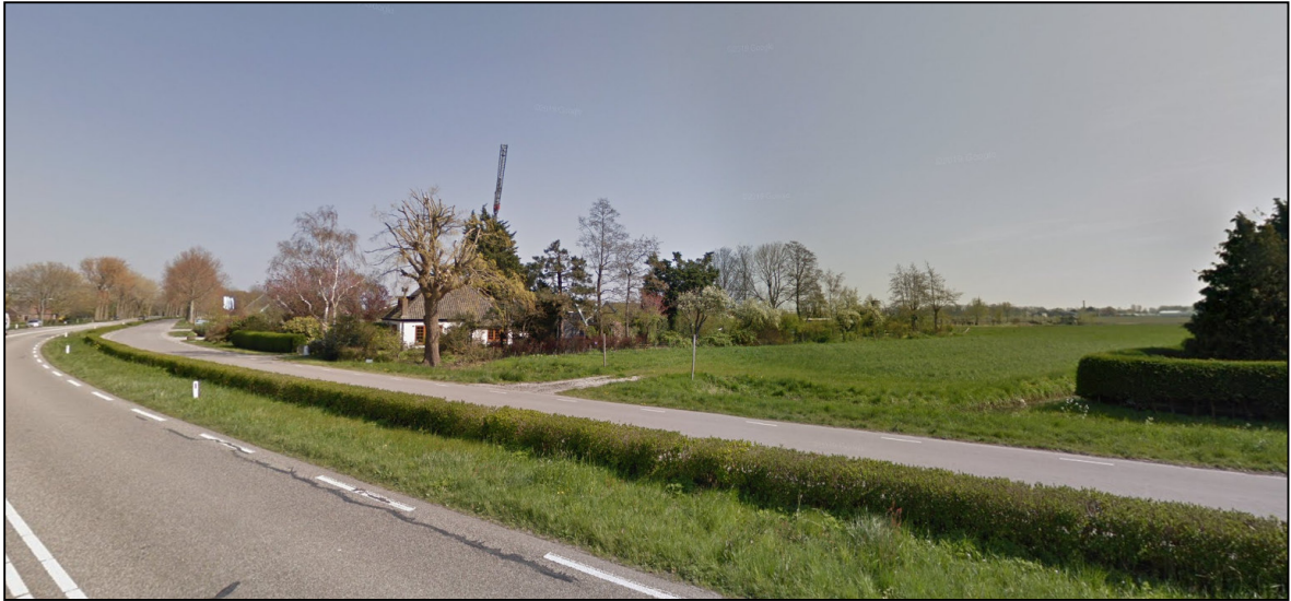
Figuur 2.1: Planlocatie De Hout 53 in Hem, bestaande situatie (bron: Google Streetview)
