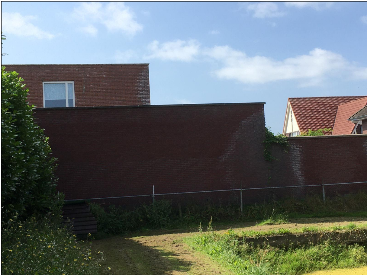
Afb 10: Nieuwe woonblok zal 2m vanaf dit bestaande woonblok gebouwd worden. Open stootvoegen ontbreken waardoor het uitgesloten is dat er een verblijfplaats aanwezig is in de spouw van deze muur
