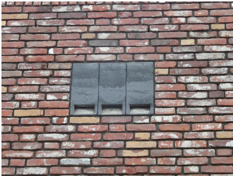
Figuur 4: inmetzelstenen vleermuis. Er bestaan ook voorzieningen waarbij alleen een invliegopening zichtbaar is. Goede voorzieningen als deze zijn onderhoudsvrij.
