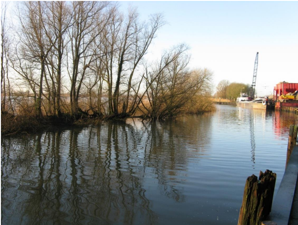
Figuur 6 Loskade Bergambacht
