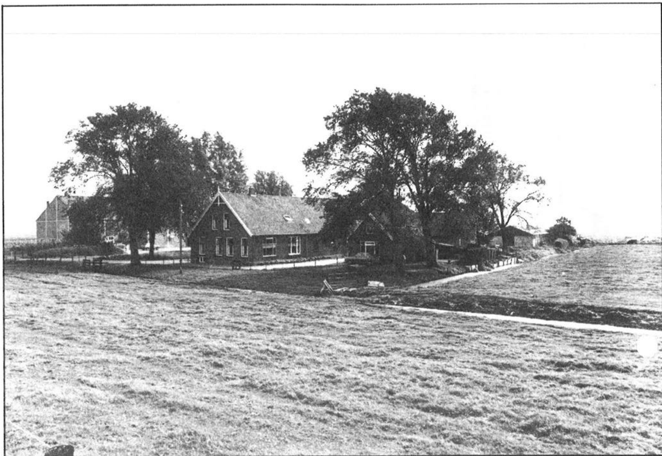
Het talud bij de Ringdijk
