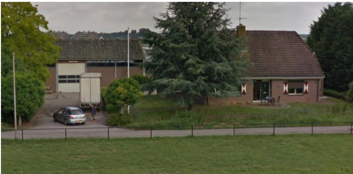
Figuur 2.2: bedrijfsbebouwing en -woning Ziedewijdsenade 72
