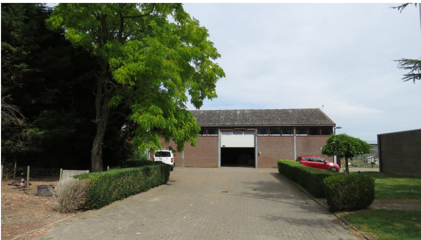
Afbeelding 9: Zicht op de schuur aan de Ziedewijdssekade.
