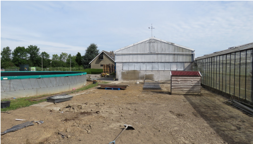
Afbeelding 5: De schuur, het bassin en de kassen aan de 3e Barendrechtseweg.
