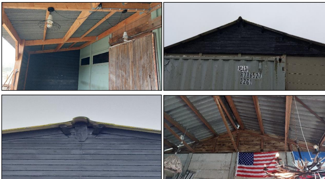
Figuur 7: Muren en het dak van de schuur en de paardenstal.
