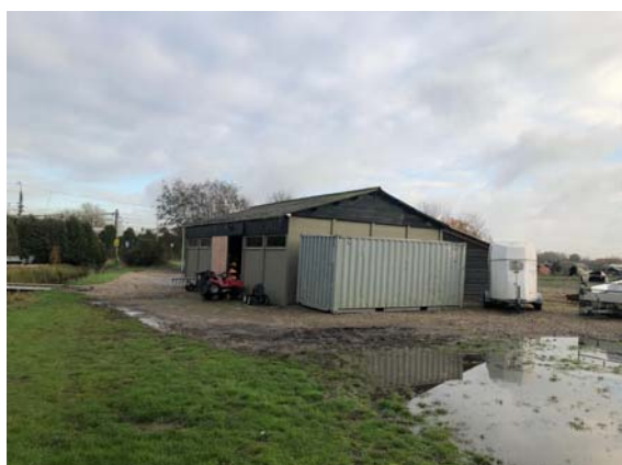
Schoor voorzien van golfplaten en dakgoten
