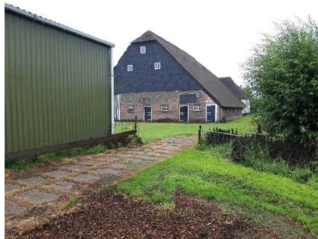
Foto 2: Tuin ten westen van de opstallen, t.h.v. boring 408 richting het zuiden.
